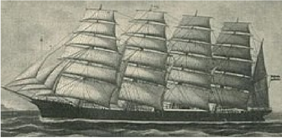
Fünfmastbark „Potosi“ der Reederei F, Laeisz, Hamburg, erb. 1895 von Joh. E. Tecklenborg Geestemünde. 4026 BRT. 3755 NKT, Länge 111,4 m, Breite 15,18 m, Raumentiefe 9,20 m.
