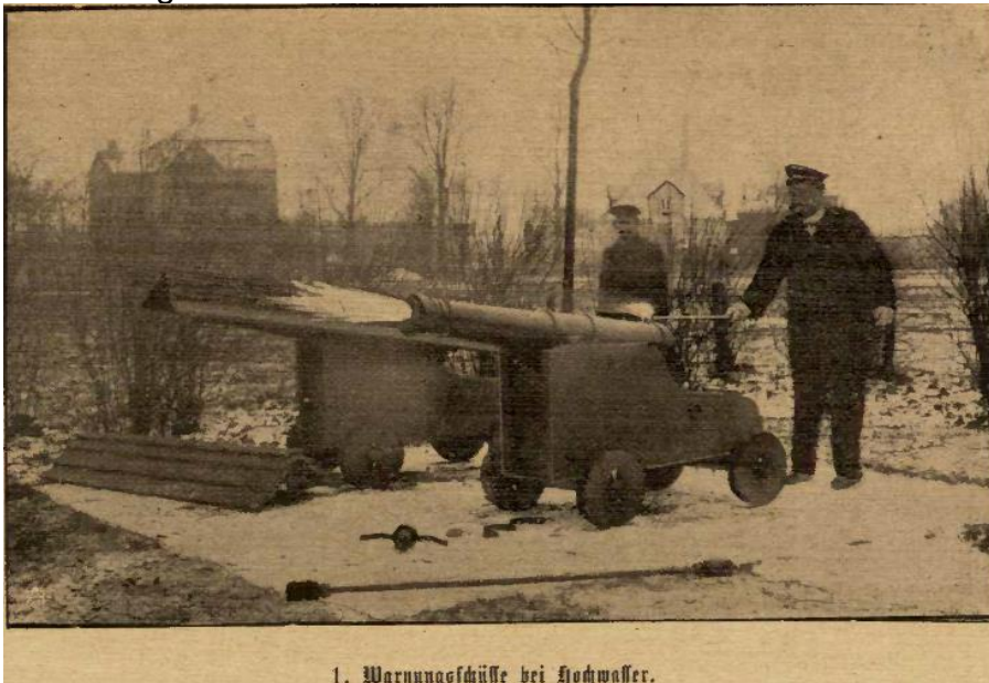
1. Warnungeschütze bei Hochwasser.
